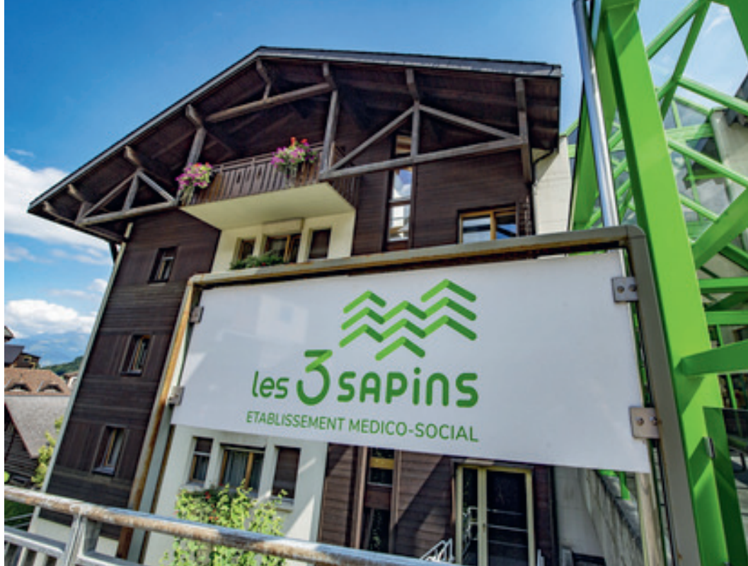
L'emplacement de l'EMS n'est pas idéal pour des séniors manquant d'autonomie. Une fois qu'il aura déménagé, l'idée est d'adapter le bâtiment pour qu'il accueille des appartements protégés.
